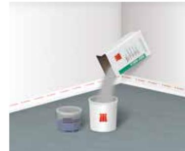
5 Einfüllen der Ausgleichsmasse in abgemessene Wasservorlage
