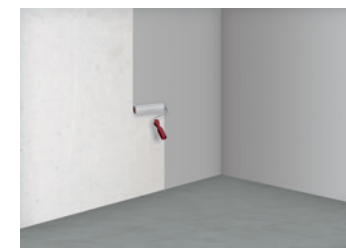
7 Auftragen der Grundierung auf der Wand
