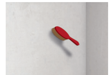
2 Reinigen des Wanduntergrundes
