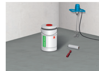
3 Grundierung und geeignetes Werkzeug
