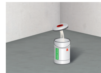
5 Vollständiges Entleeren der Härter- in die Harzkomponente und anschl. Vermischen
