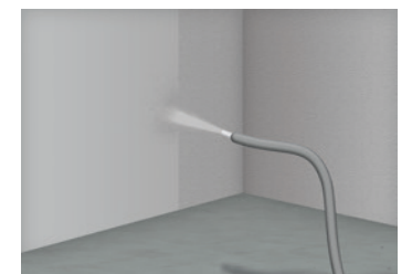
8 Vollflächiges Abstreuen der frischen Grundierung mit Quarzsand
