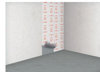
6 Verklebung der SANIFIN-Bahnen mit Überlappung
