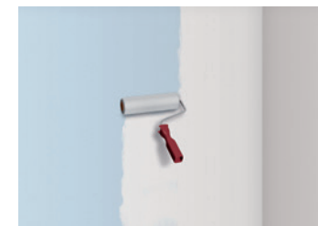
3 Grundieren des Untergrundes, z.B. mit ASO-Unigrund
