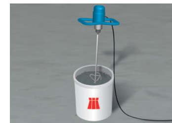
5 Anmischen der Spachtelmasse
