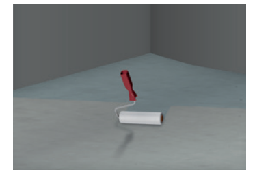
8 Grundieren des Untergrundes, z.B. mit ASO-Unigrund
