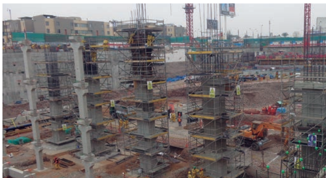
► Impalcature a torre nella costruzione di pilastri
