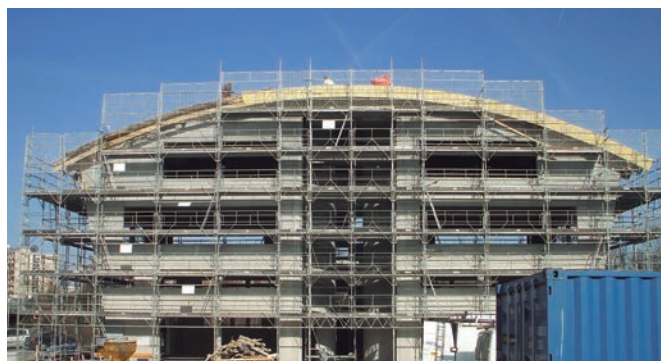
► Protezione in gronda in opera
