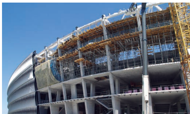
► Costruzione di solai a sbalzo in sicurezza
