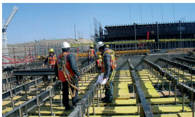
► Montaggio puntellazione in sicurezza
