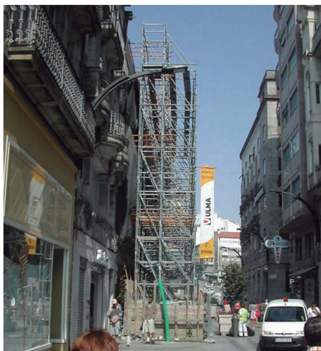
► Stabilizzazione di una facciata con l'utilizzo del ponteggio BRIO
