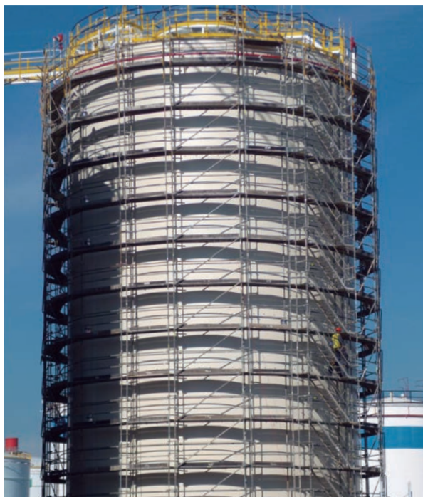
► Manutenzione di un serbatoio
